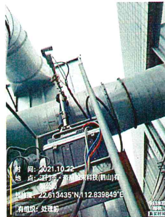
图 2: 有组织废气处理前监测点
